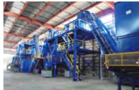
ASRリサイクル施設
