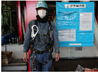
フルハーネス型墜落制止用器具の使用
