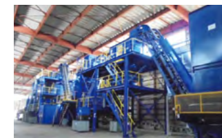
ASRリサイクル施設
