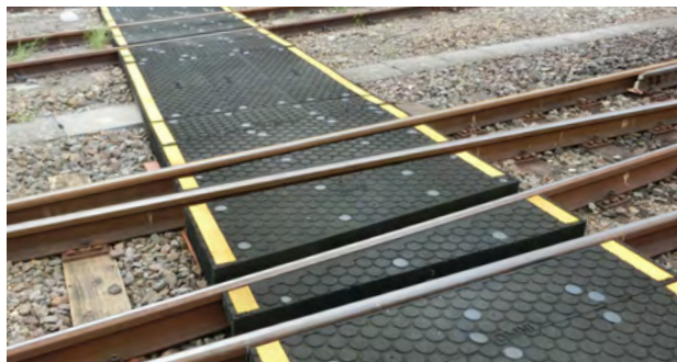
オムニゴムパネル施工 歩行者用カラーラインパネル
